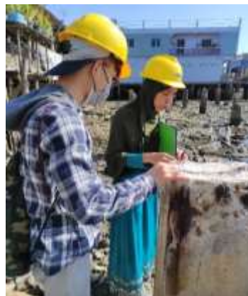
Gambar 5. Proses Pengukuran Tiang Pondasi (Sumber: Penulis, 2023)
