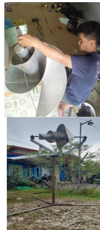
Gambar 4. Pemasangan seluruh komponen turbin angin tipe ulir
