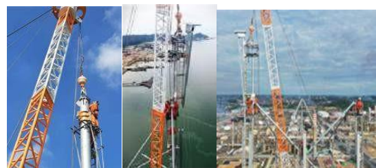
Gambar. 5 Metode Instal Struktur Ujung Atas Sumber : PT. Kilang Pertamina Balikpapan (2022)
